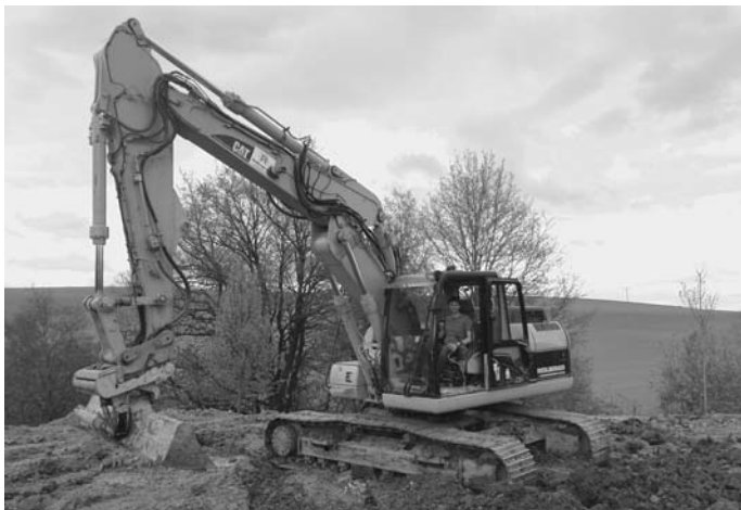
Robert Riedlberger mit schwerem Gerät bei der Verlegung der Drainagerohre.
