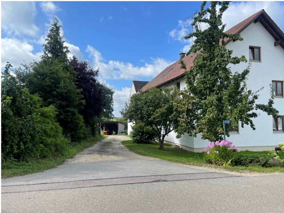
Abbildung 2: Blick von Norden aus der Lindenstraße auf die bestehende Zufahrt Fl.Nr.395/5, mit Blick auf das Bestandsgebäude Fl.Nr. 16 (Haus Lindenstraße Nr. 12) im Vordergrund, Aufnahme vom 17.08.2021
